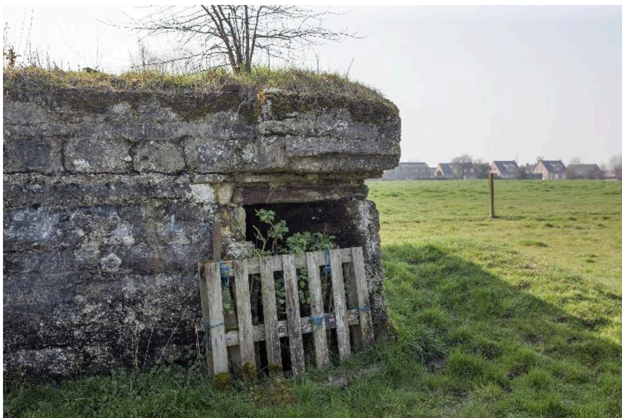
Porte sur l'angle nord-est
