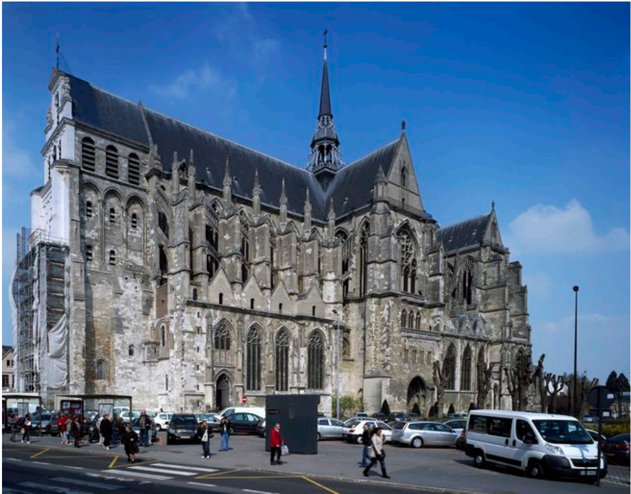
Vue de l'élévation sud.
