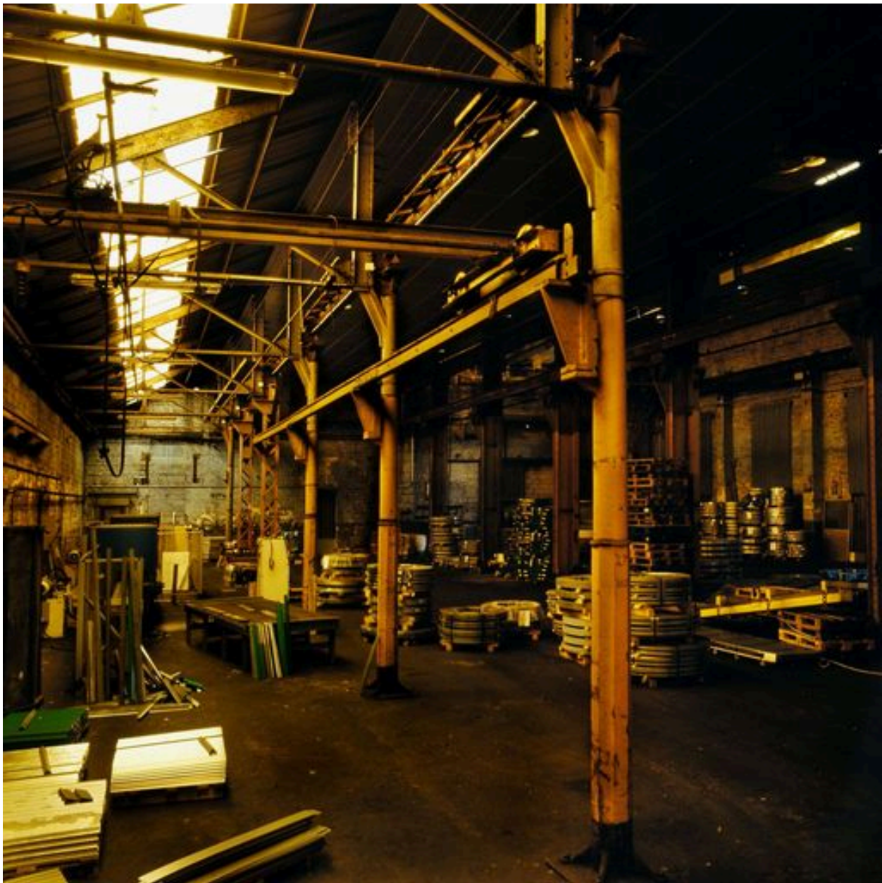
Enfilade des colonnes en fonte.
