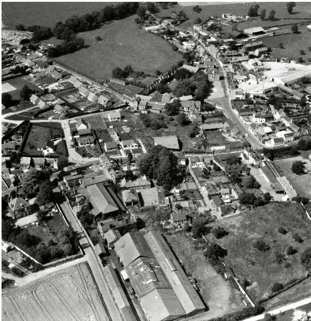
Vue aérienne du village depuis le sud, en 1988.
