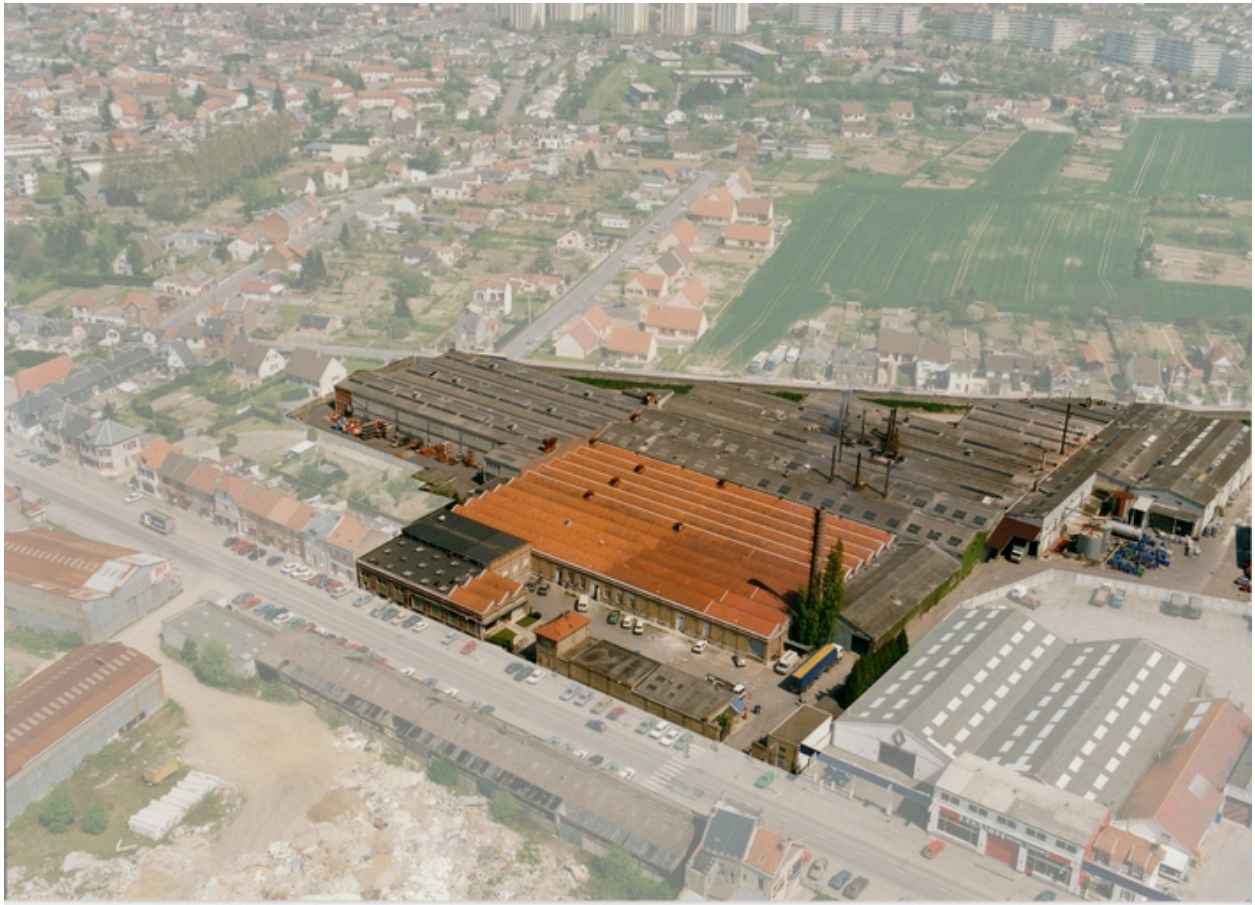
Vue aérienne vers 1990 (BM Saint-Quentin).
