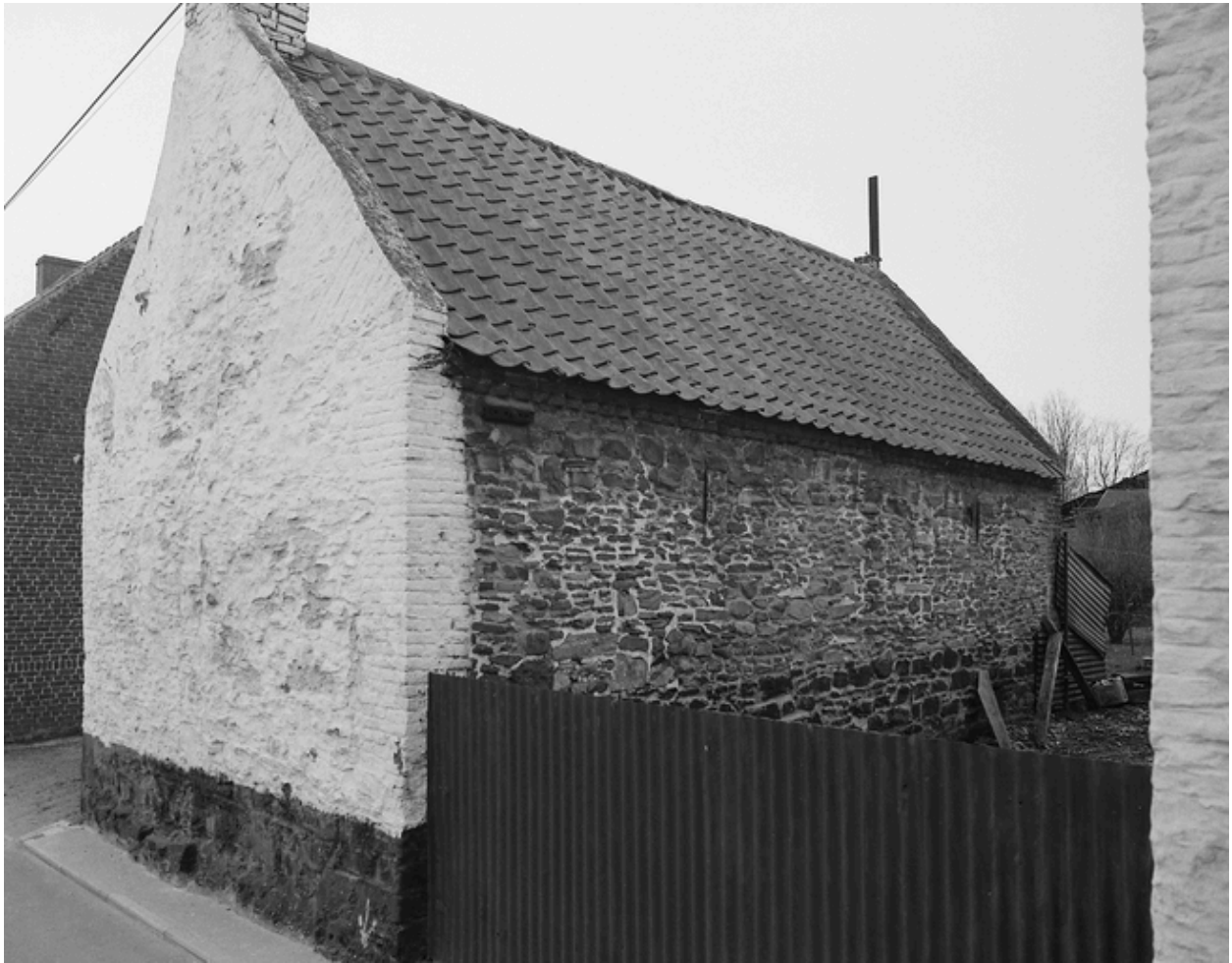
Ferme élémentaire Grand'Rue, la mise en oeuvre du logis.
