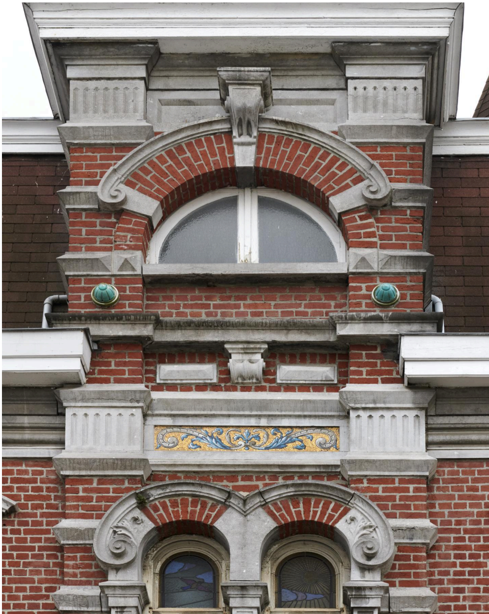
Détail : pignon droit de la façade rue Descartes.
