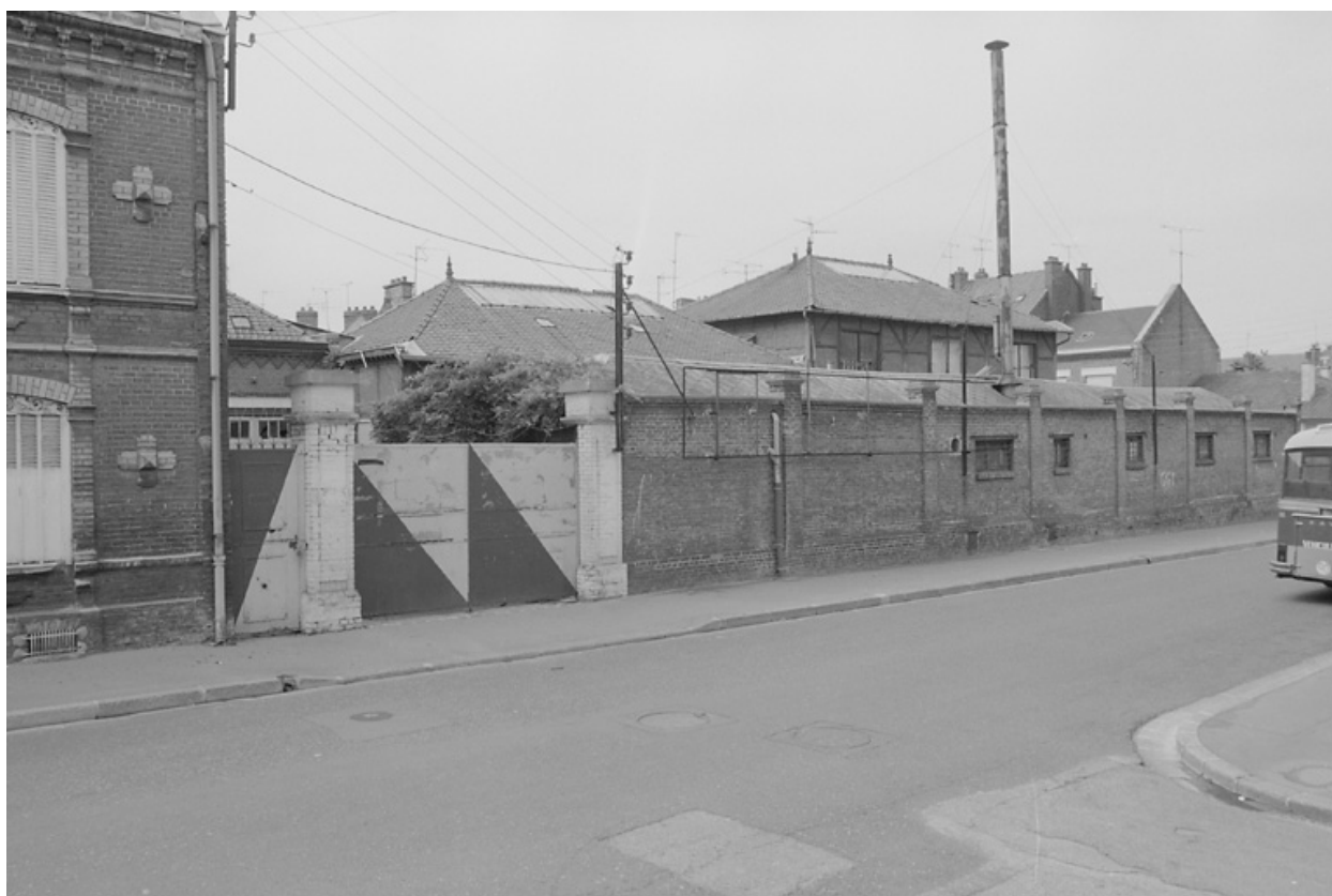
Ateliers de fabrication, flanc est.
