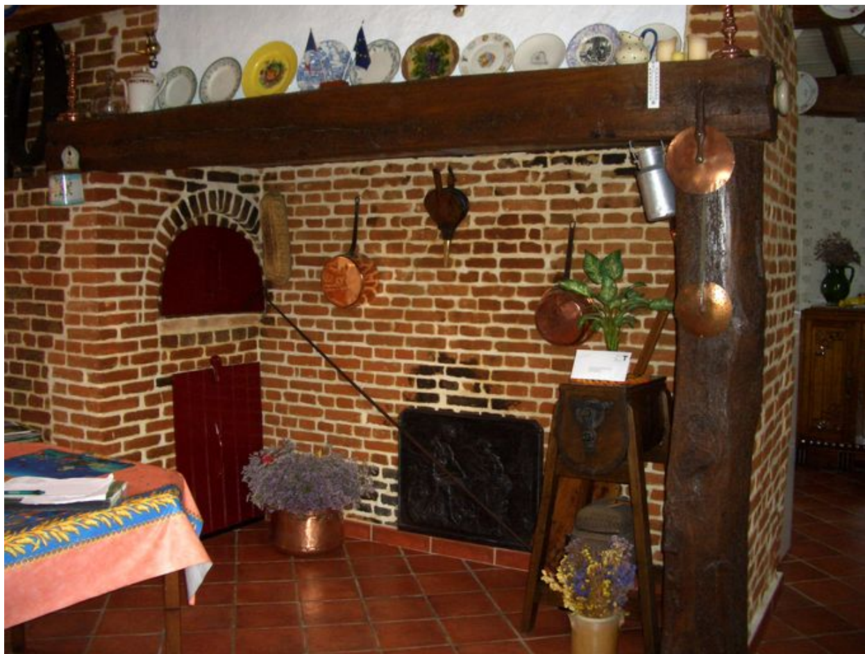
Vue d'une cheminée traditionnelle avec four à pain sur le côté gauche et cafourneau en-dessous.
