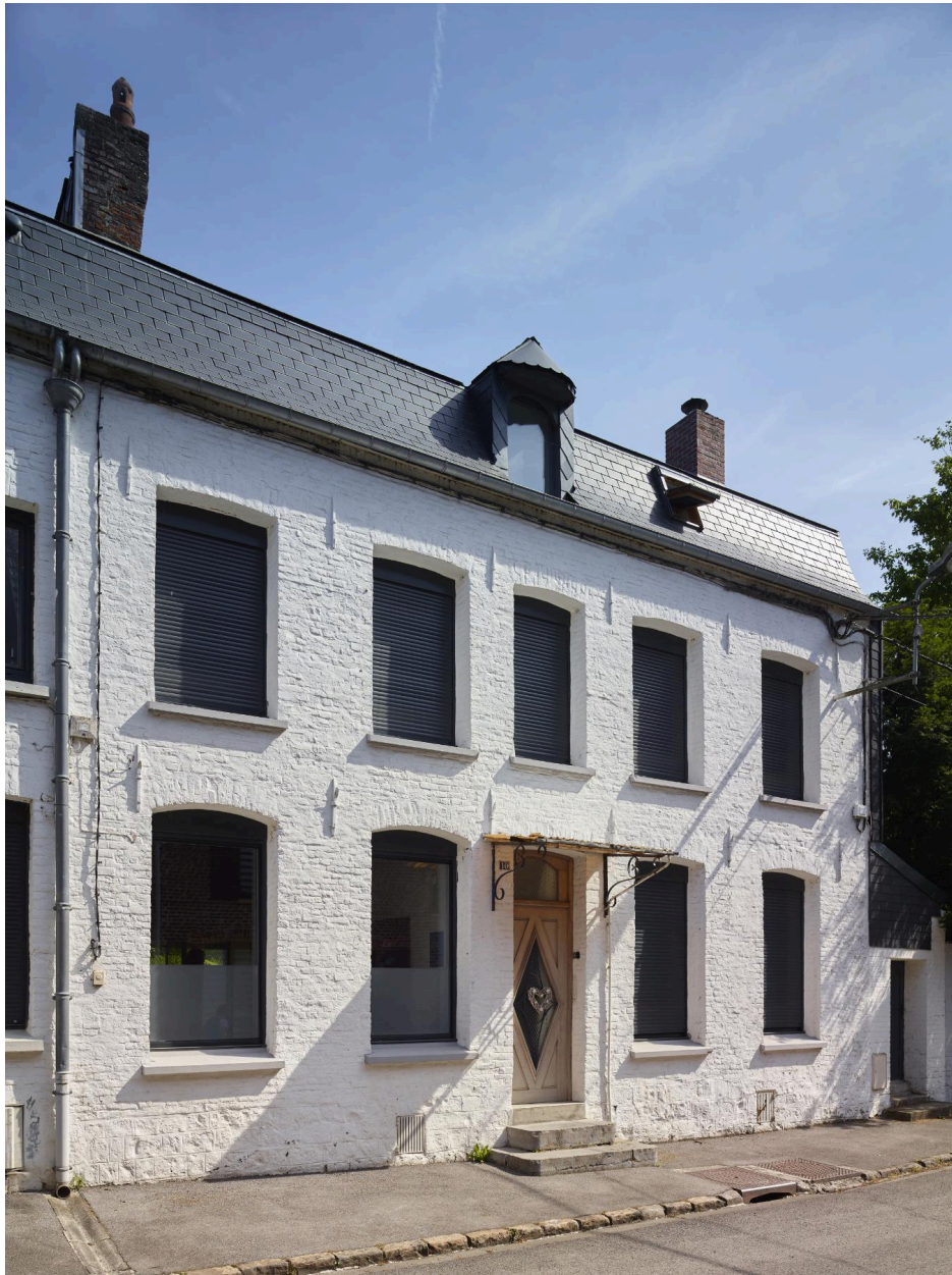
Maison, début XIXe siècle : degrés en pierre bleue, façade ordonnancée de 5 travées, marquise, toiture brisée et lucarne en guitare - 10, rue des Lombards.
