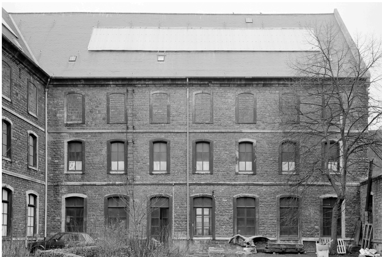
Aile en retour d'équerre, façade sur cour.
