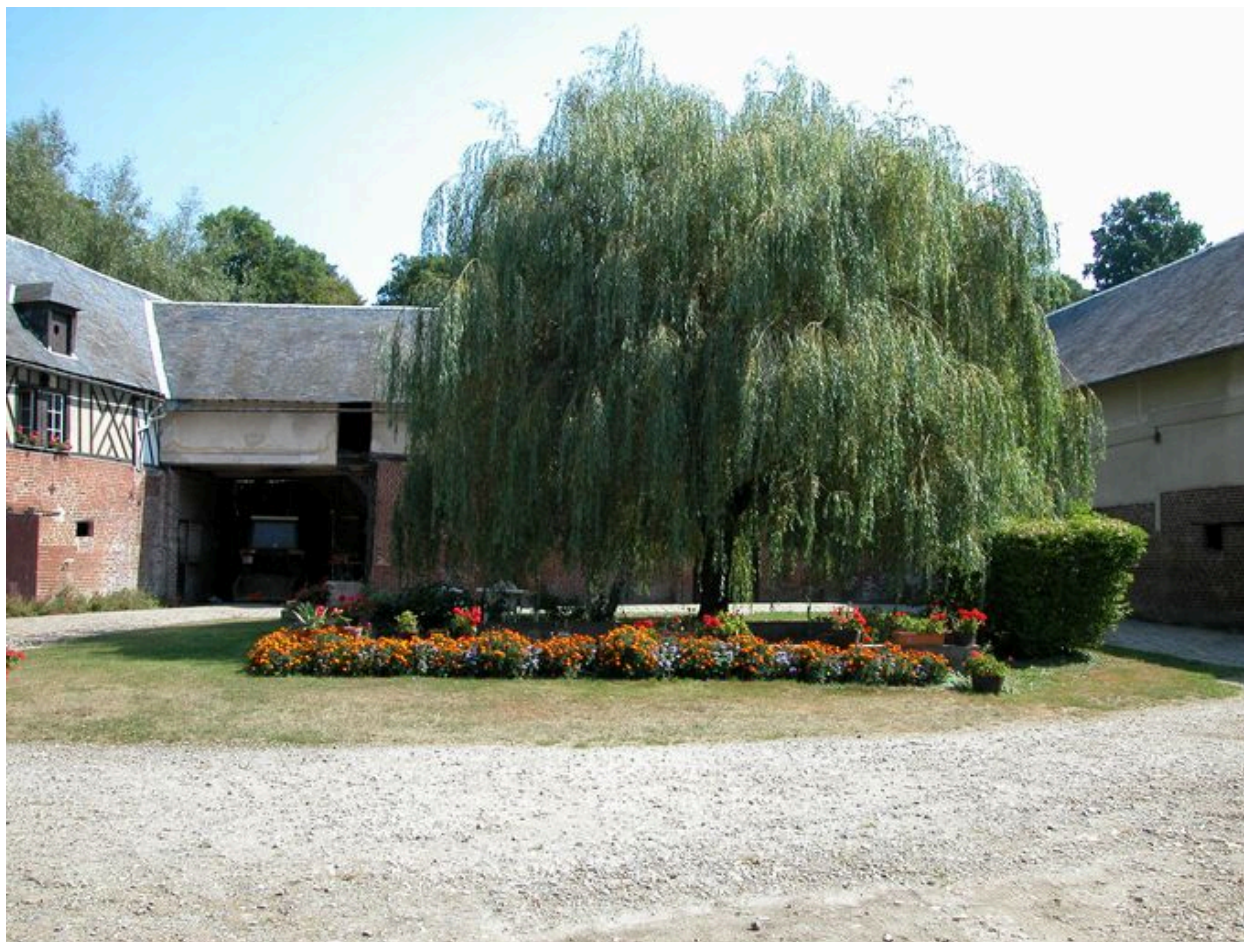
Façades sur cour des granges et dépendances agricoles du moulin.
