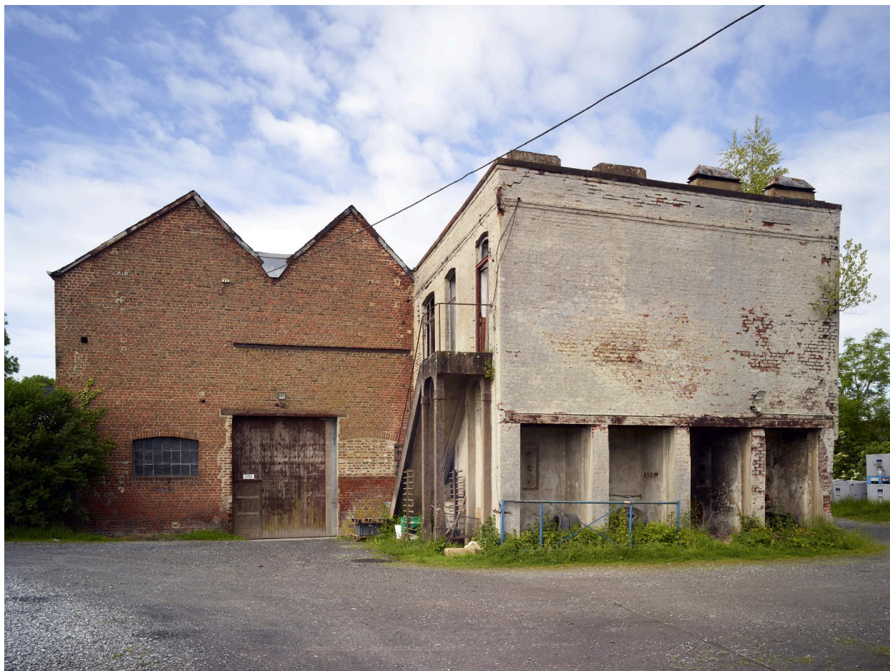
Bâtiment jouxtant la salle des générateurs, vue générale.
