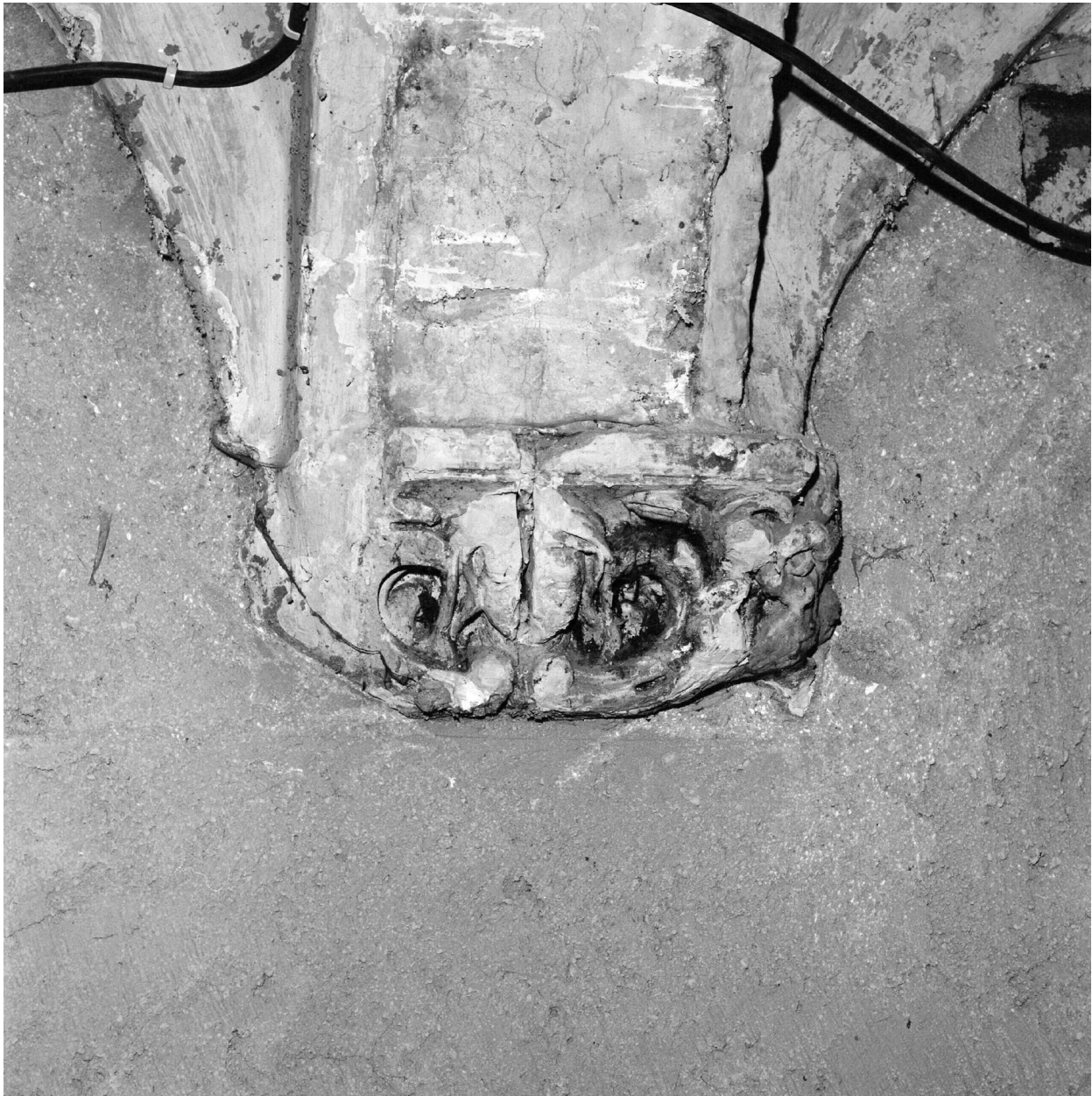
Intérieur, rez-de-chaussée, salle conventuelle : chapiteau avec figuration d'un visage de religieuse (?), état en 2005.
