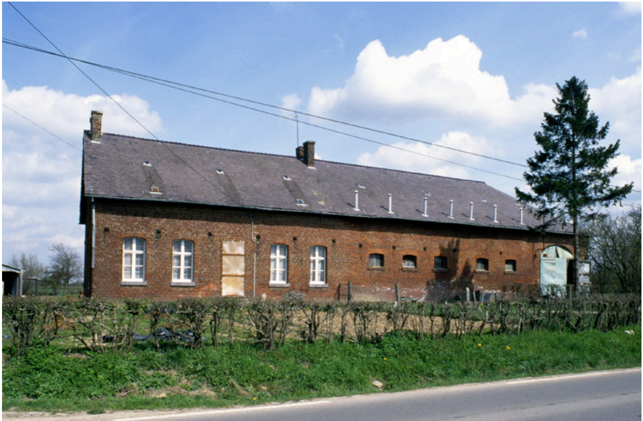
Vue de la ferme est.
