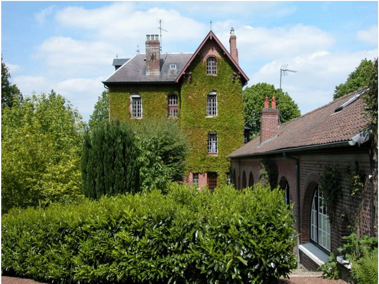
Vue d'ensemble depuis le quai du Romerel.
