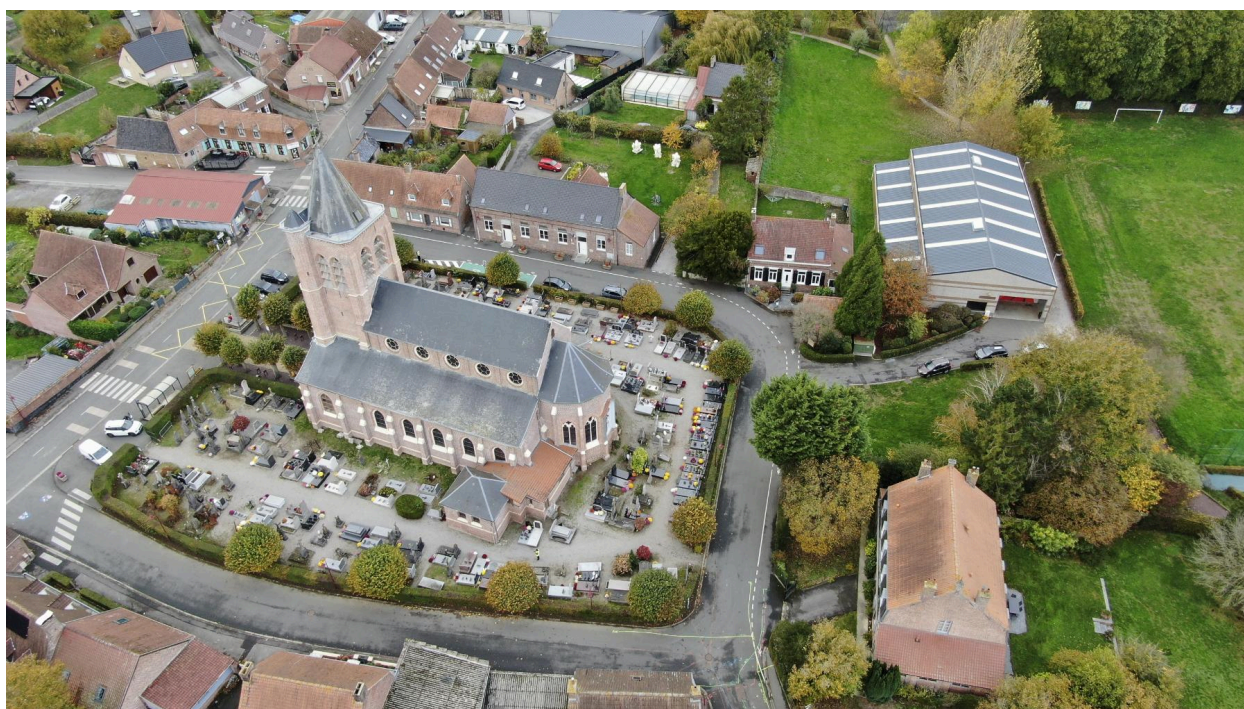
Vue aérienne de l'église depuis le sud-est.
