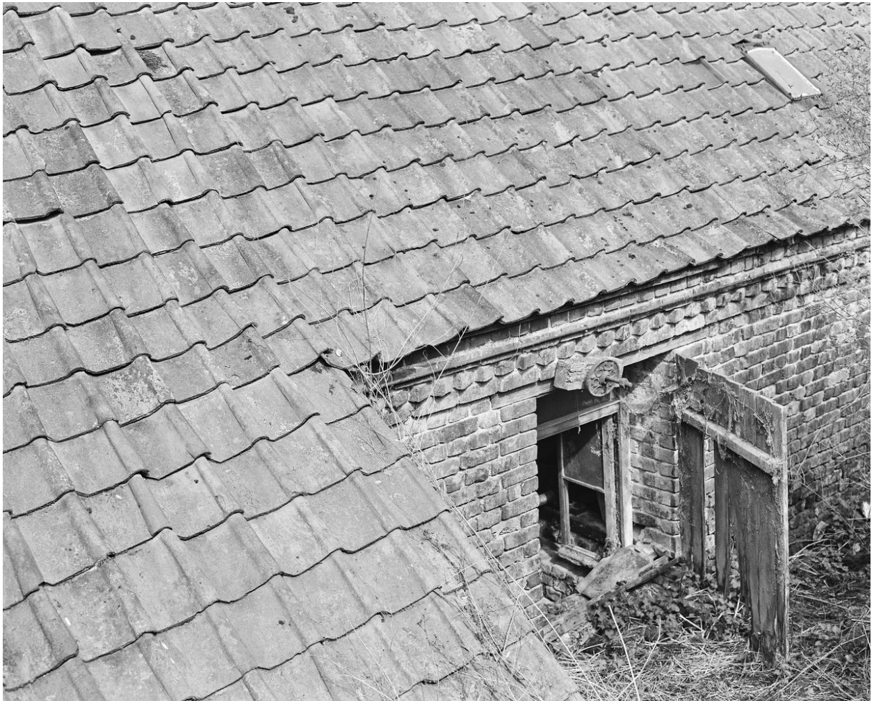
Ouverture sur le bâtiment d'eau.
