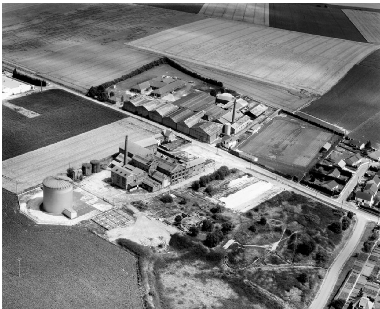
Vue aérienne, flanc nord-ouest.
