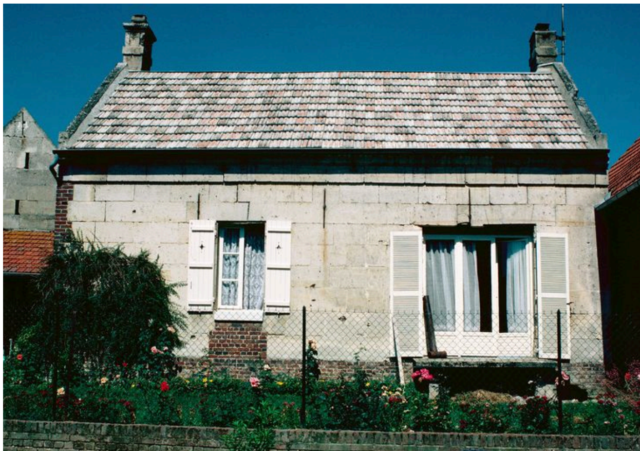
Elévation postérieure du logis d'une ferme repérée.
