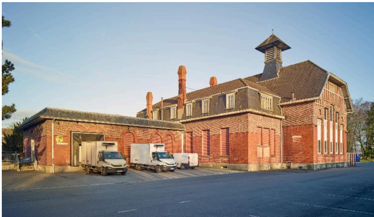
Bâtiment des cuisines, élévation antérieure, vue générale prise de trois quarts gauche.
