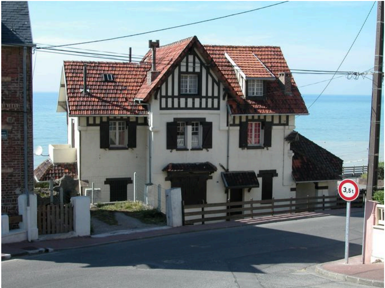
Vue d'ensemble depuis le boulevard de la mer.
