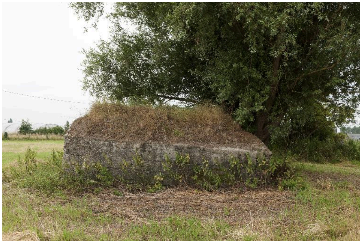
Casemate i, vue latérale vers le sud-ouest
