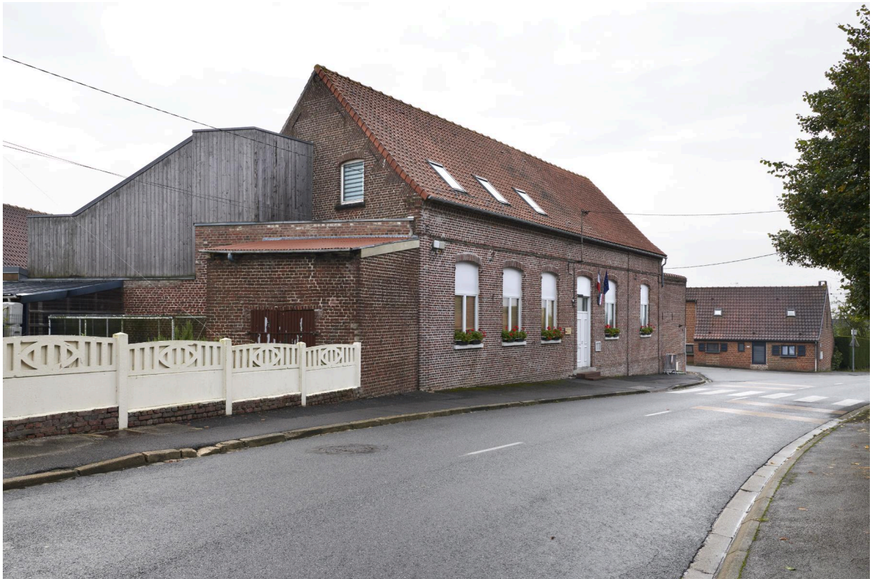
Vue depuis le nord.
