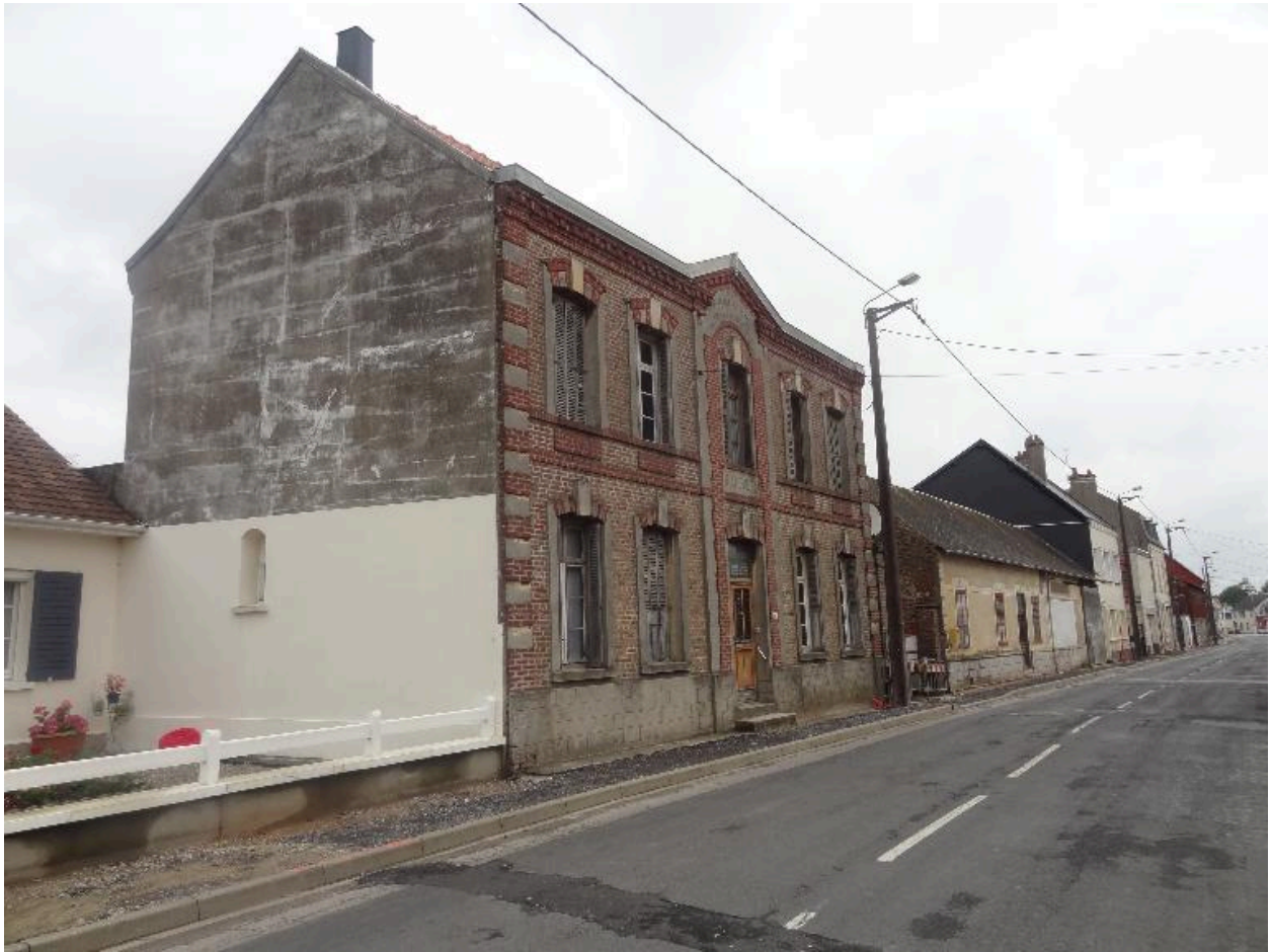
Vue d'ensemble depuis la rue Isaïe-Sellier.
