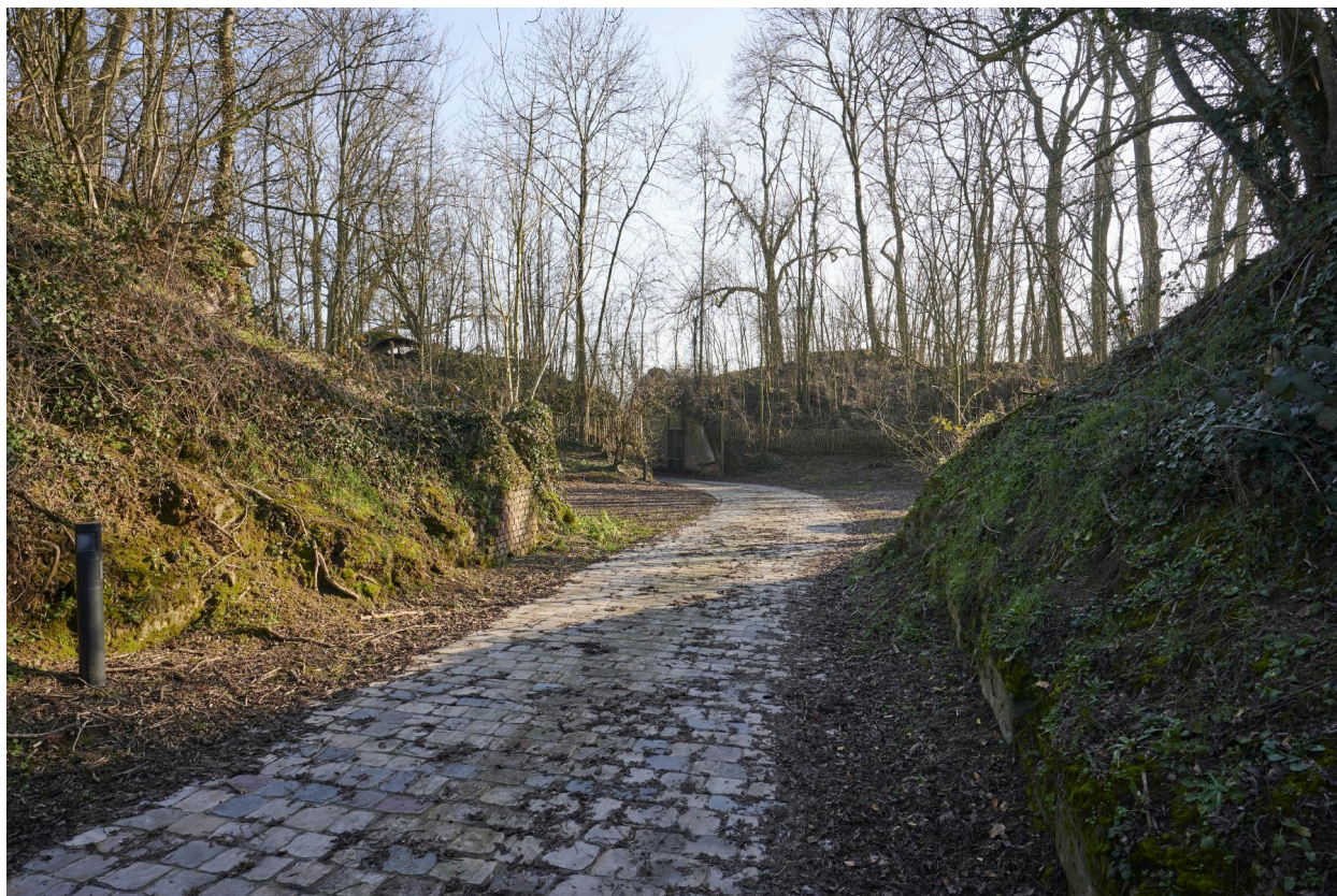
Traversée du ravelin, vers le sud.
