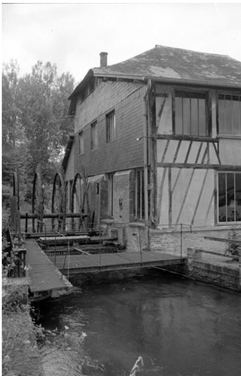
Bâtiment d'eau, flanc sud.
