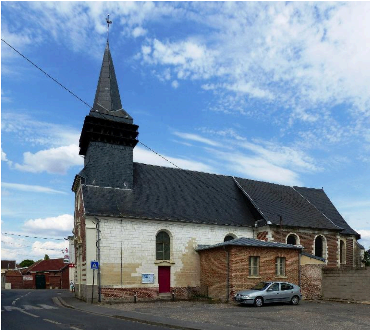
Vue de la façade sud.
