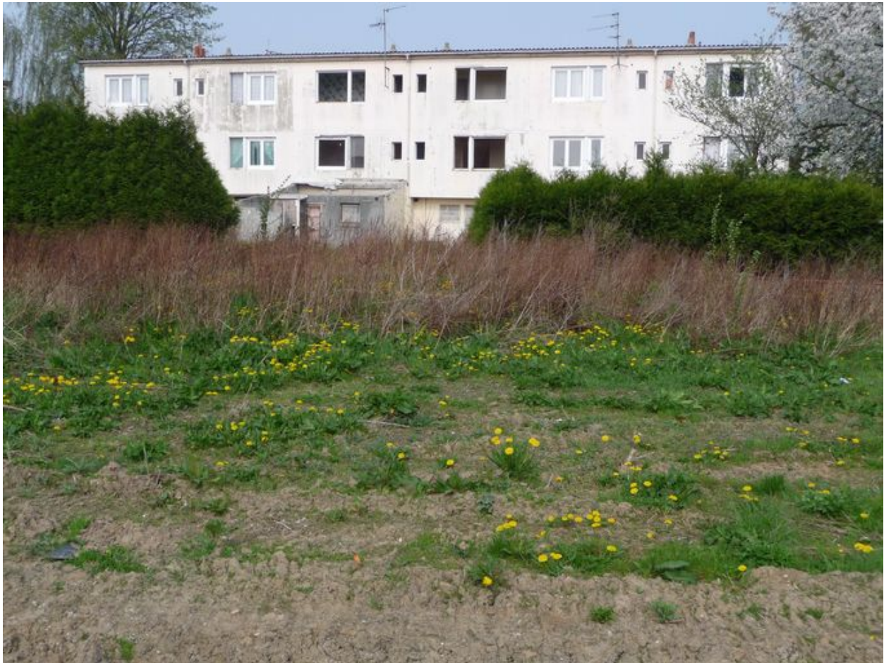
Vue générale d'un groupe de six logements.
