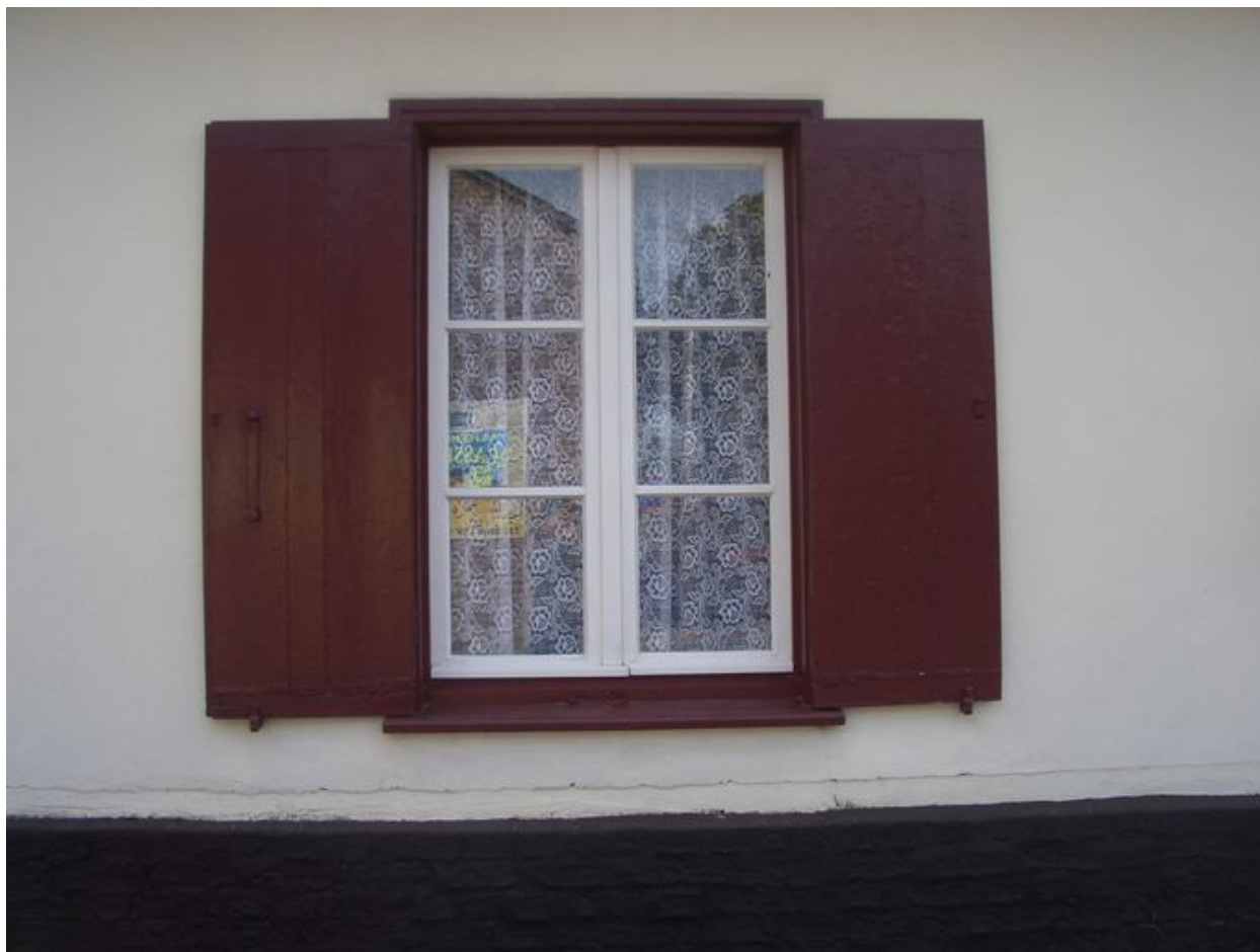
Vue détaillée d'un contrevent.
