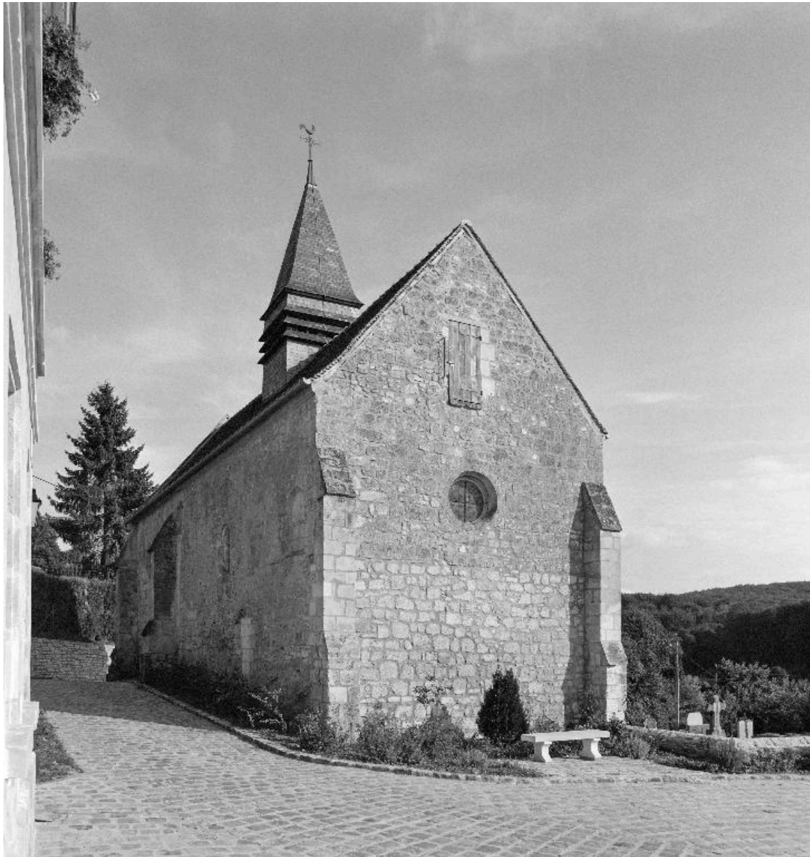
Vue de l'église, depuis le nord-ouest.
