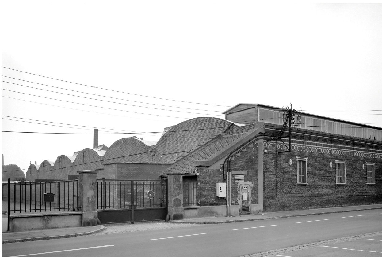
Atelier de fabrication depuis la rue de l'Octroi, vue prise vers l'est.
