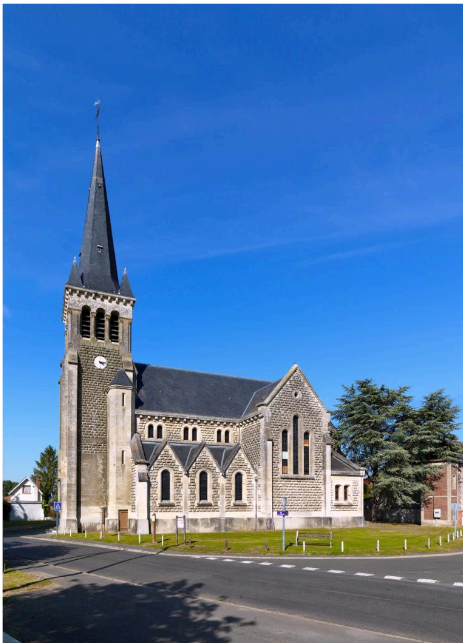
Vue de l'élévation sud de l'église.
