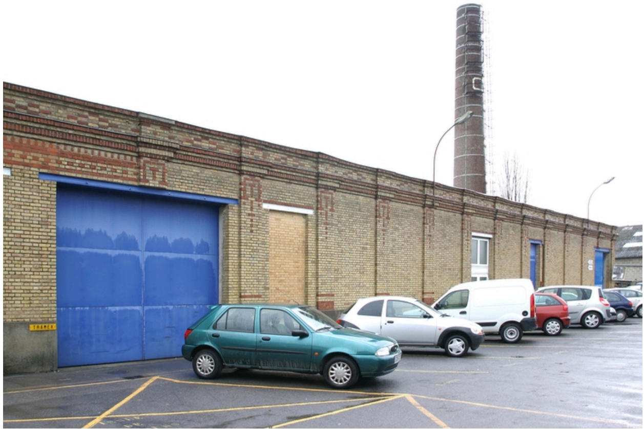
Façade antérieure des ateliers de 1920.
