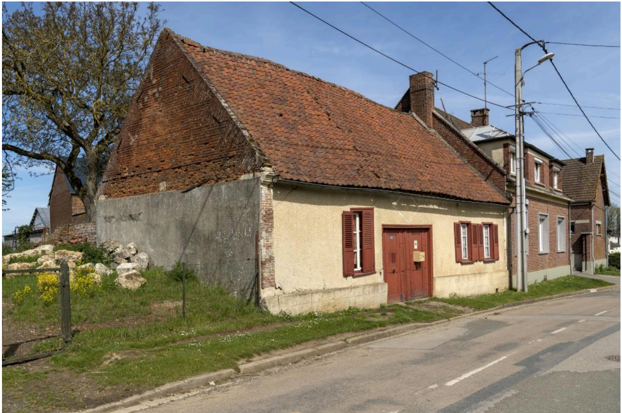
Ancienne maison de serger (?), n°62 rue Principale, vue depuis le sud-est.
