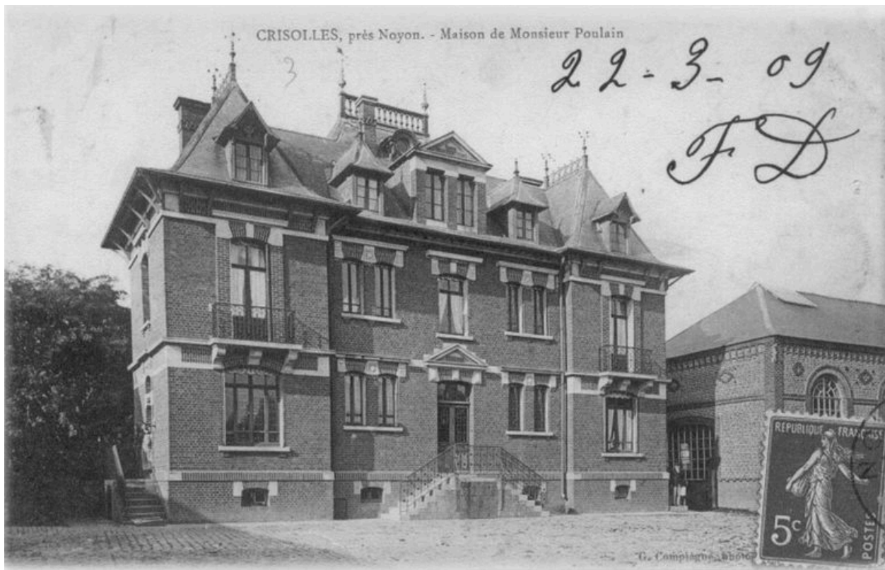
Façade sur cour, avant 1914 (AC Crisolles).
