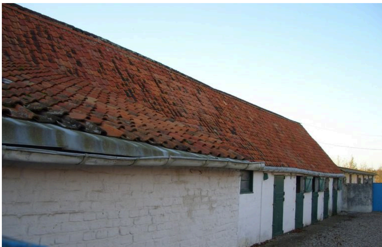
Vue des écuries.
