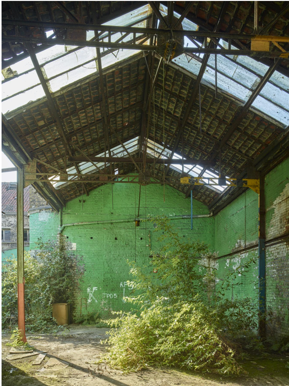
Vue intérieure, vers le sud-est, de l'atelier de fabrication ouvrant rue François-Tixier.
