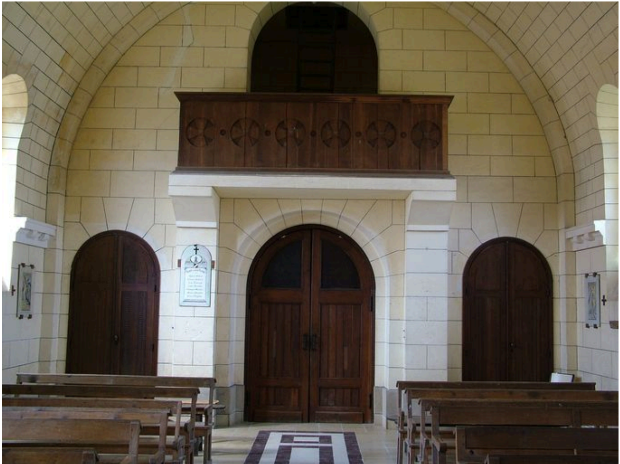
Vue intérieure du mur ouest.
