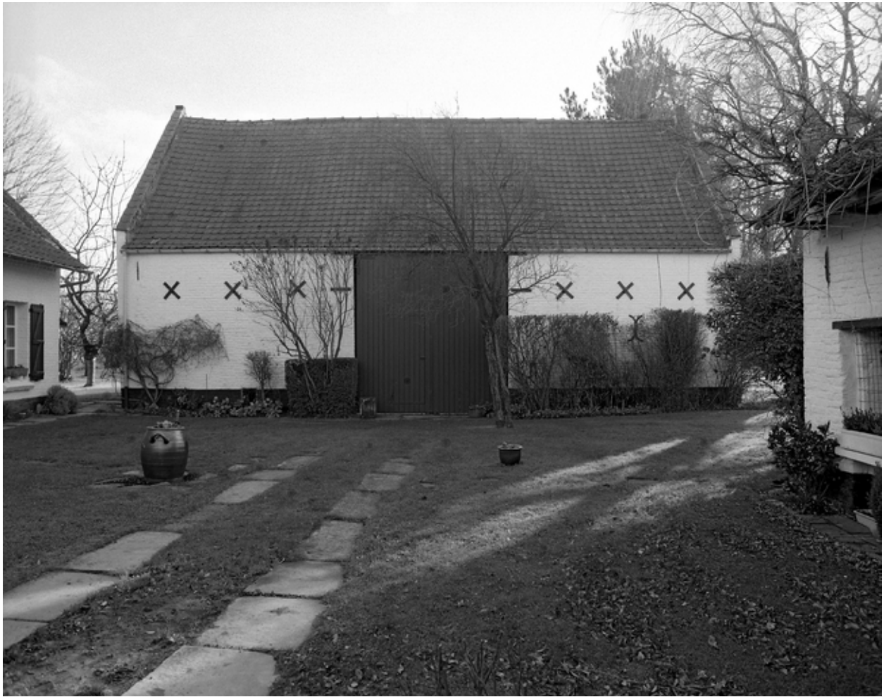
Vue générale avant restauration.
