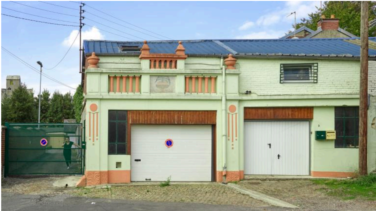
Vue de la façade.
