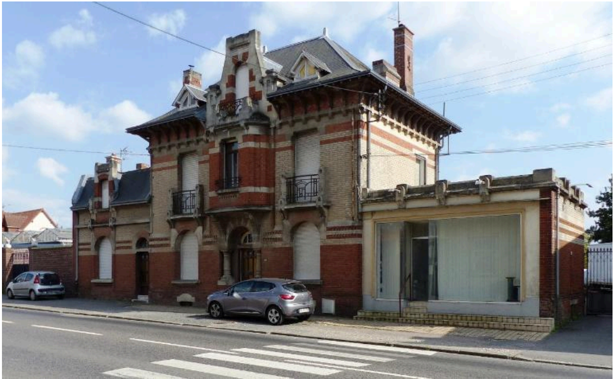
Ancienne maison du fabricant de bonneterie Jules Narcisse Lavallard.
