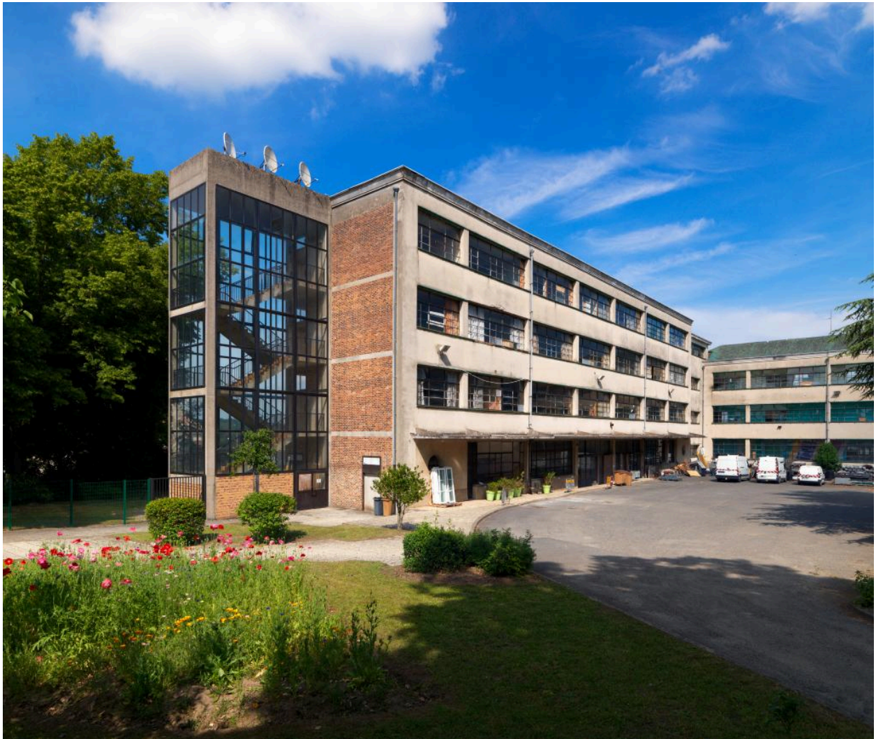
Vue générale du bâtiment en retour au nord, façade sud.
