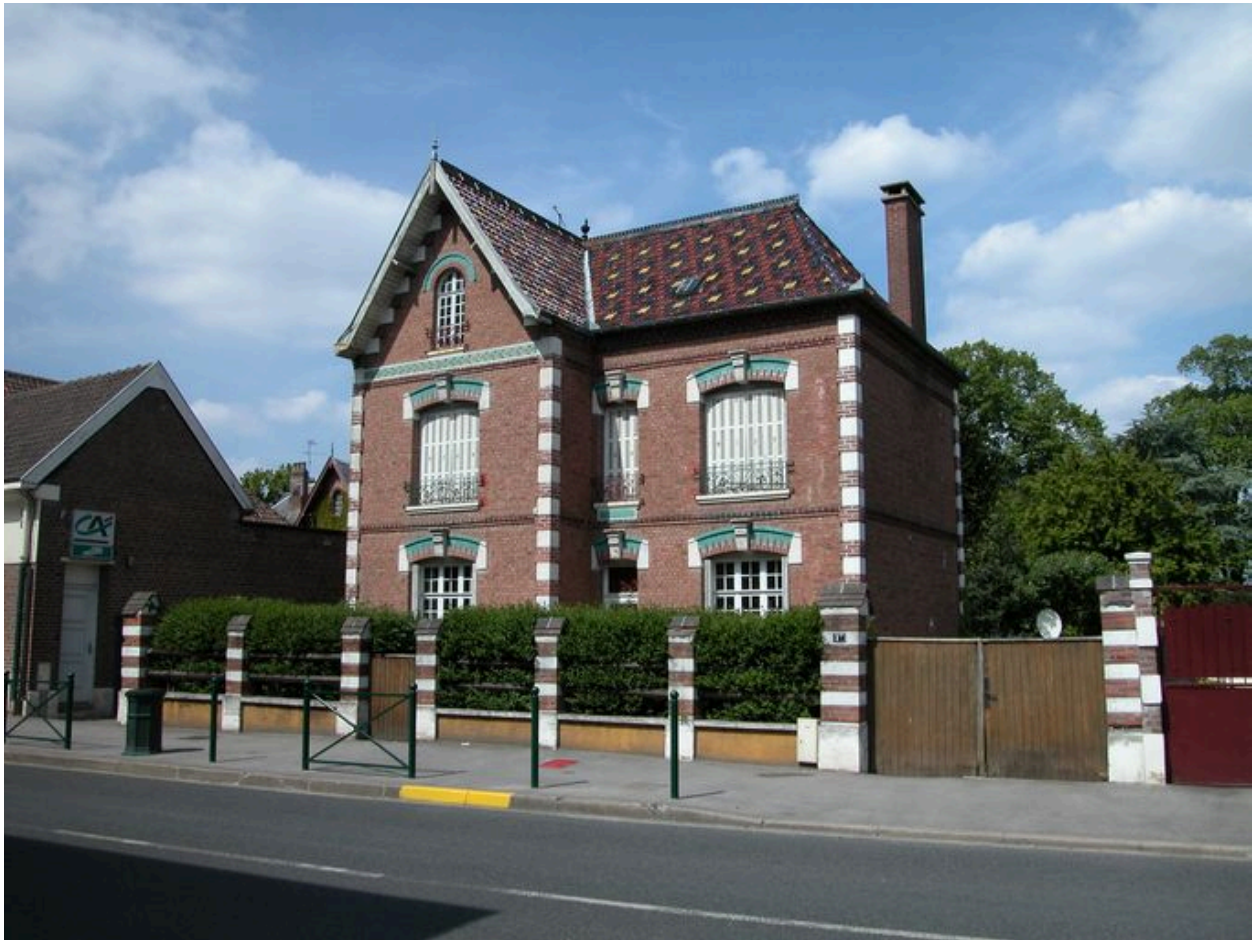
Vue d'ensemble depuis le quai du Romerel.
