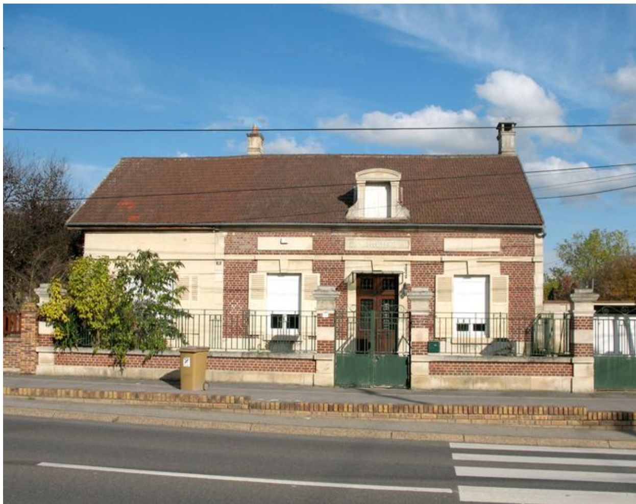
Maison du marbrier Eugène Wattebled à Nogent-sur-Oise construite en 1883 dans le quartier des briqueteries.
