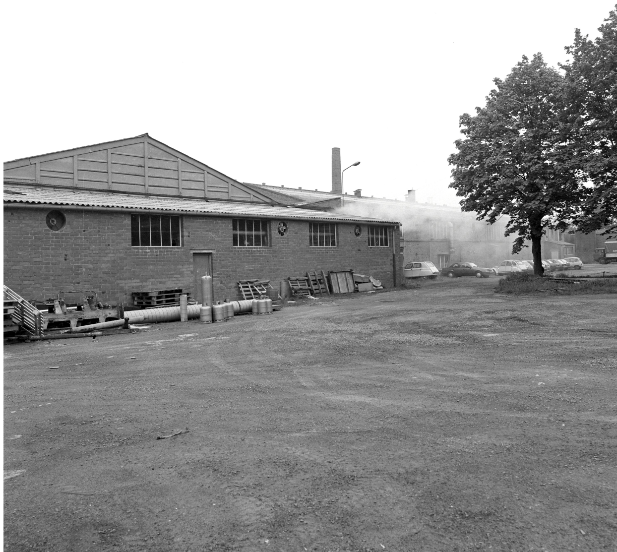
Cour vue depuis le sud-ouest.
