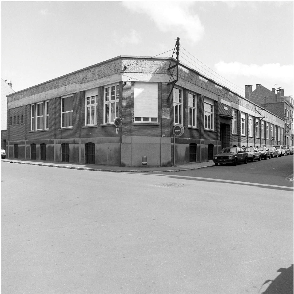
Vue générale vers le nord est.
