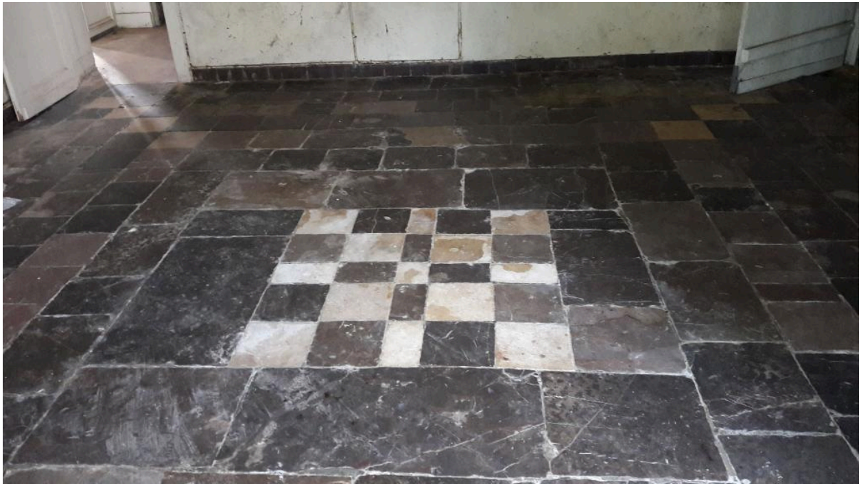
Ferme des berceaux : détail du dallage de la laiterie associant pierre bleue et calcaire blanc. (Coll. part.)
