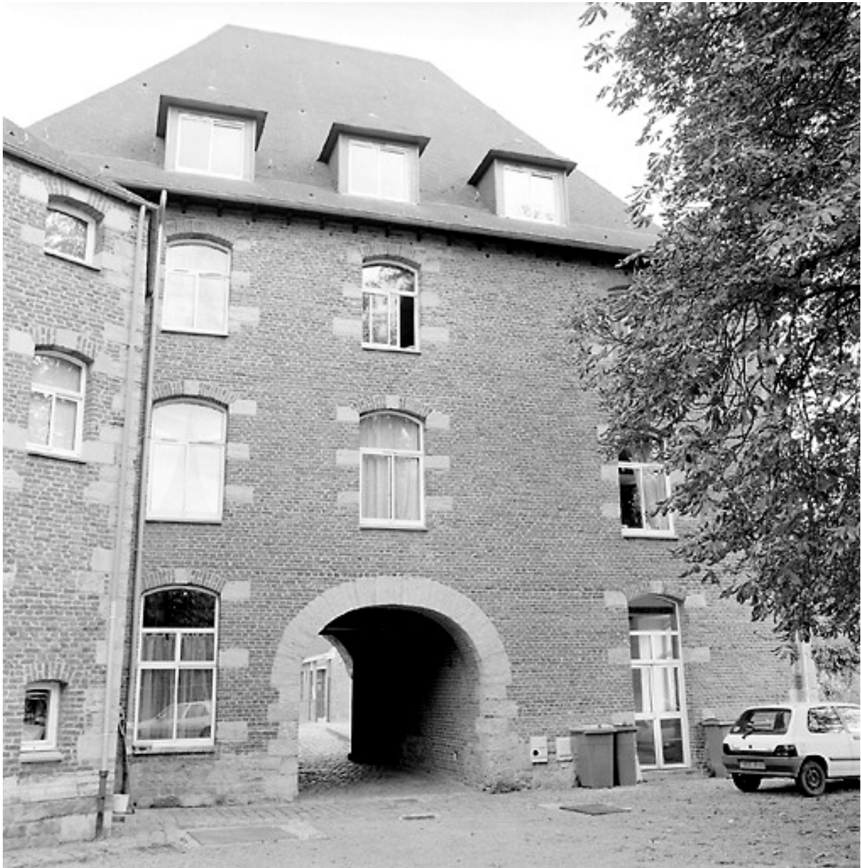
Ouvrage d'entrée, revers, vue générale.
