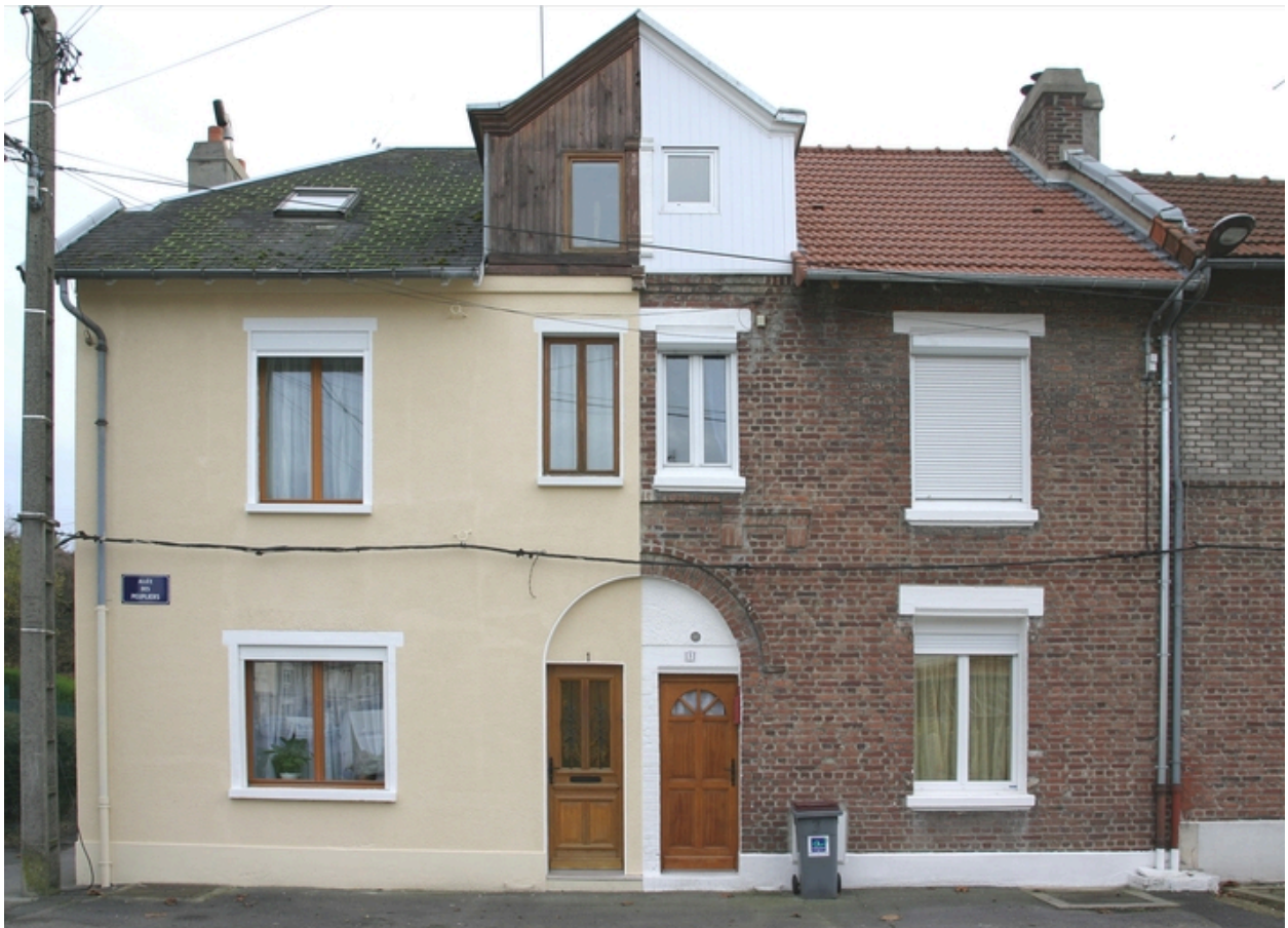
Deux logements au début de la rue des Peupliers.
